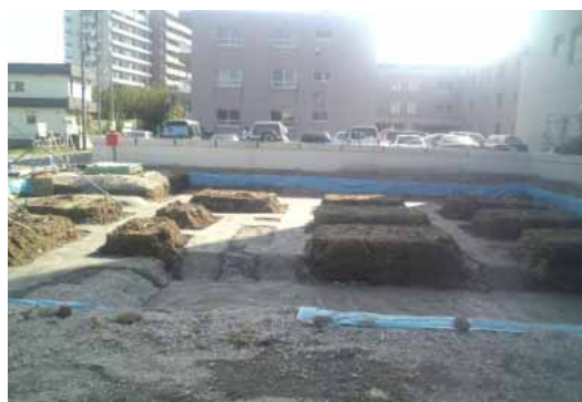
【基礎工事の様子】
